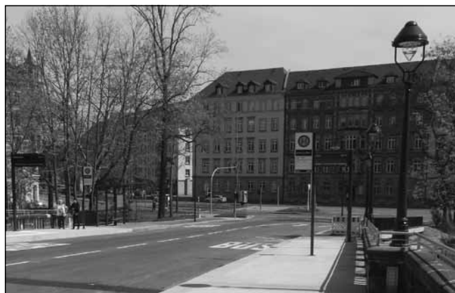
Von allen Verkehrsteilnehmern herbeigesehnt, ist die Kaßbergauffahrt seit Mitte April nach gründlicher Sanierung wieder frei. Ein Wermutstropfen: Es wurde kein Radweg integriert.
