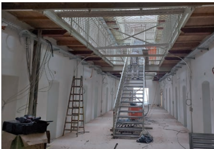
So hat es im April auf der Baustelle ausgesehen.
