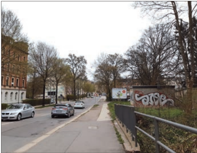
Beyerstraße wird zur Baustelle.
