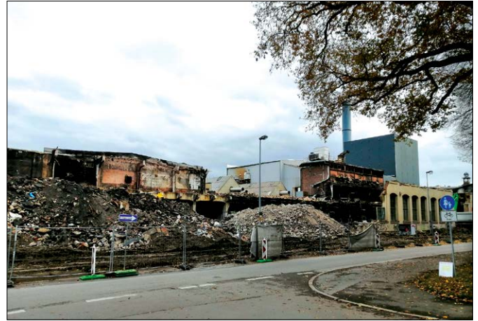
Die historische Halle wurde zum Jahresende abgerissen. Foto: buelei39
