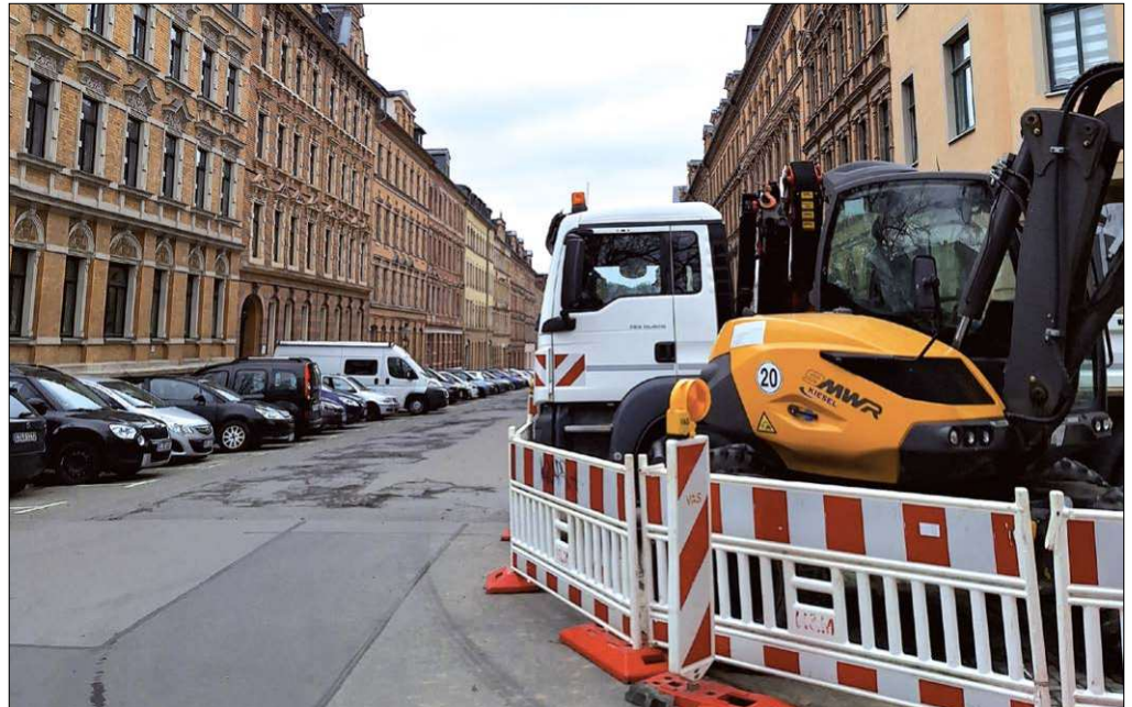
Die Lohrstraße wird schon bald zur Dauerbaustelle, Autos müssen hier weichen.
