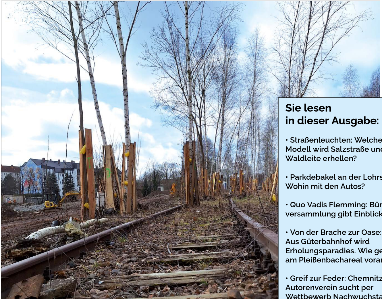
Am Pleißenbach in Altendorf wird gebaut und schon bald gepflanzt.
