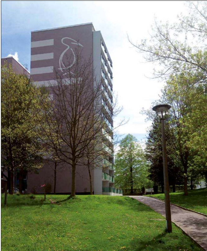
Saniertes Punkthochhaus der CSg
