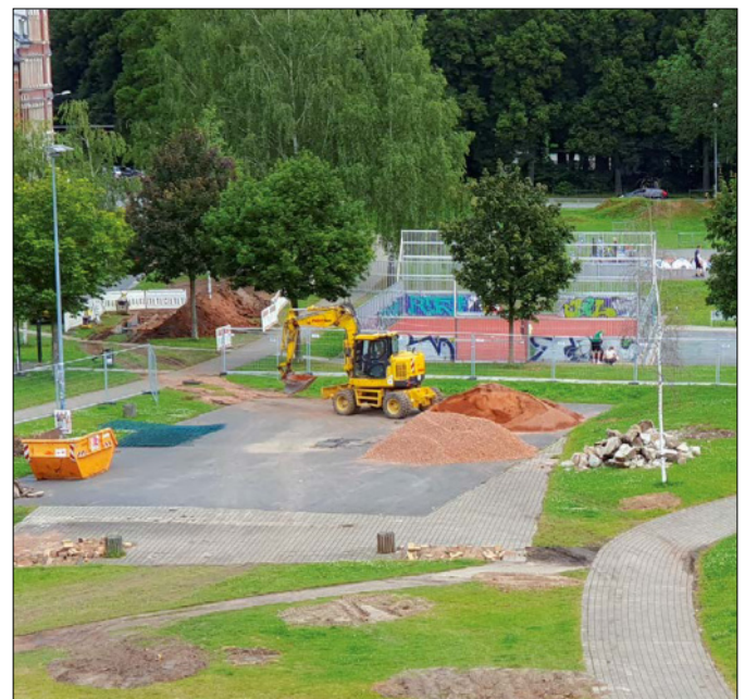
Ein Blick auf die Baustelle.
