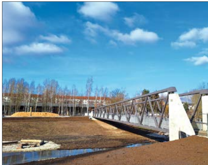
Brücke in Altendorf freigegeben
