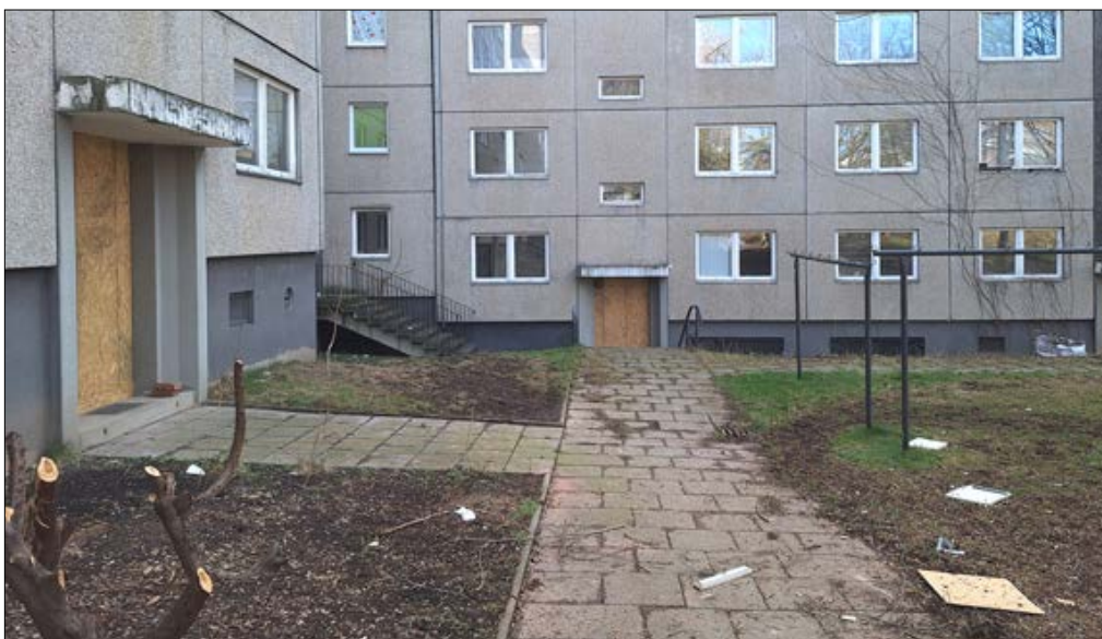
Mittlerweile wurde der Innenhof geräumt, einige Eingänge wurden abgesperrt.
