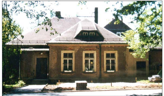
Haus 19 1994 vor der Sanierung
