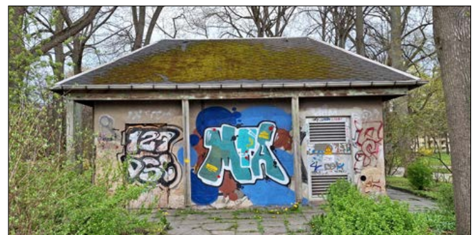
Hier könnte wieder eine Toilette entstehen.
