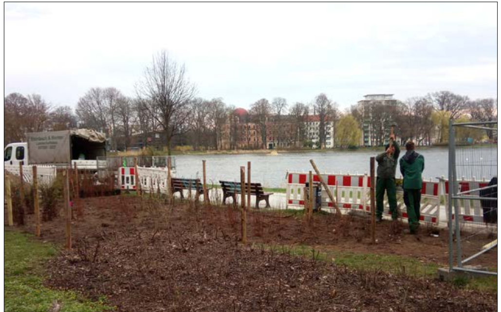
Neubepflanzung im nordwestlichen Bereich des Areals
