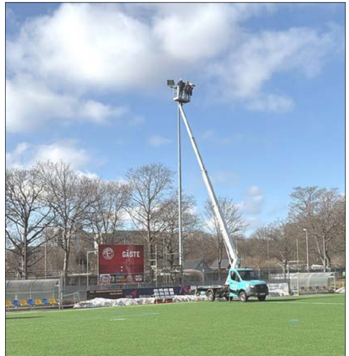
Die neue Flutlichtanlage wird montiert
