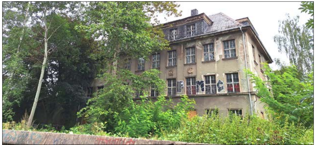
Bald wird die Fassade in neuem Glanz erstrahlen
