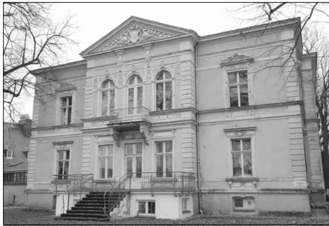
Schön, doch dringend sanierungsbedürftig: die Hartmannvilla des Kraftwerk e.V.
